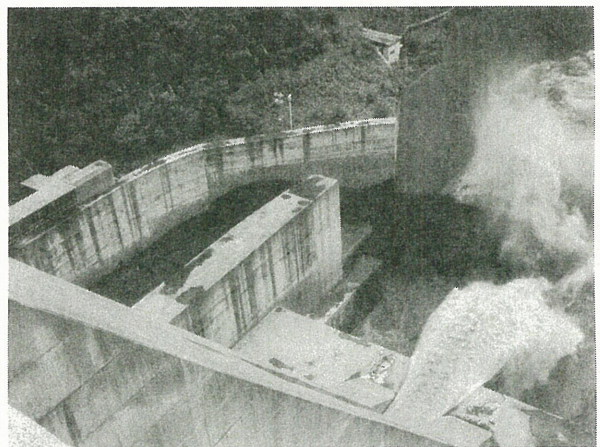
2004年7月18日に連携排砂を行う宇奈月ダム。左の黒い水が排砂ゲートから出た土砂・有機物。右の通常ゲートの白い水とのコントラストに注目。
